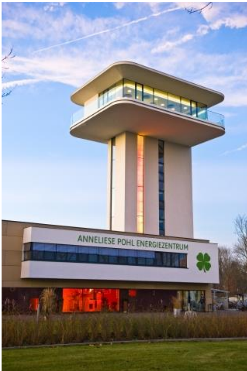
Abbildung 25: Energiezentrum im VILA VITA Pannonia
